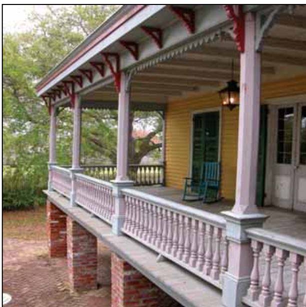
Foto: Ralph Ricknese. Las casas tradicionales de Nueva Orleans estaban protegidas del sol, elevadas para evitar las inundaciones y hechas de materiales duraderos.
