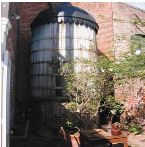
Foto: Ralph Bicknese. Las cisternas de almacenamiento de recogida del agua de lluvia son habituales en las primitivas viviendas de Nueva Orleans.
