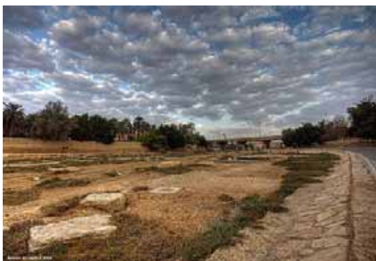
Cauce restaurado y paso de carretera al fondo
